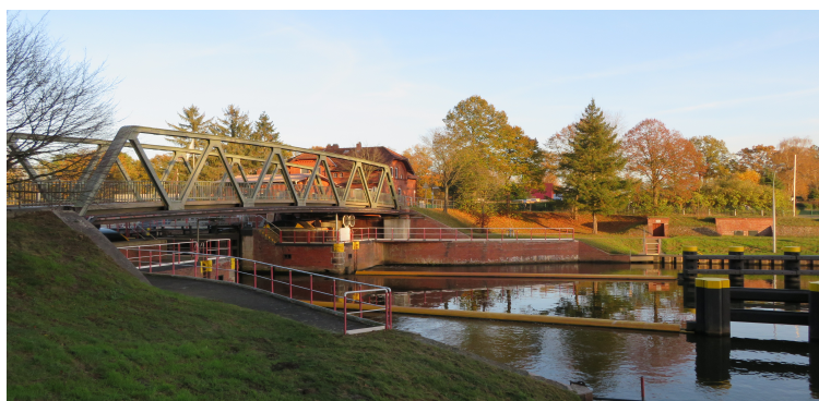
Die Baustellen zum Ausbau des ELK (s.a. Anlage 1)
